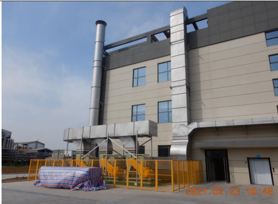
图 3-2 项目有组织废气收集处理装置图
